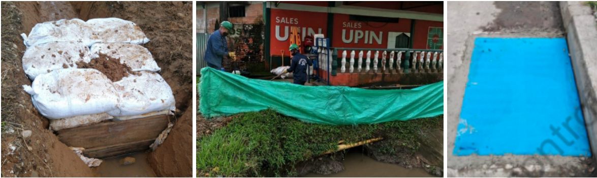
Imagen 4. Medidas de protección arrastre de materiales
