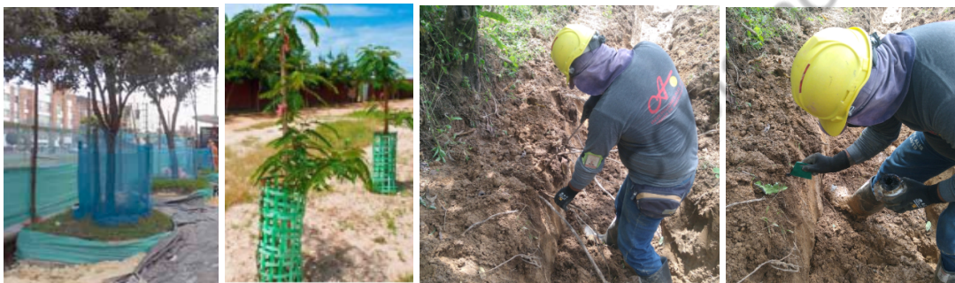
Imagen 7. Recomendaciones para la protección de árboles y corte de raíces
