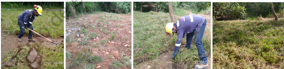
Imagen 6. Proceso de descapote y revegetalización de zona
