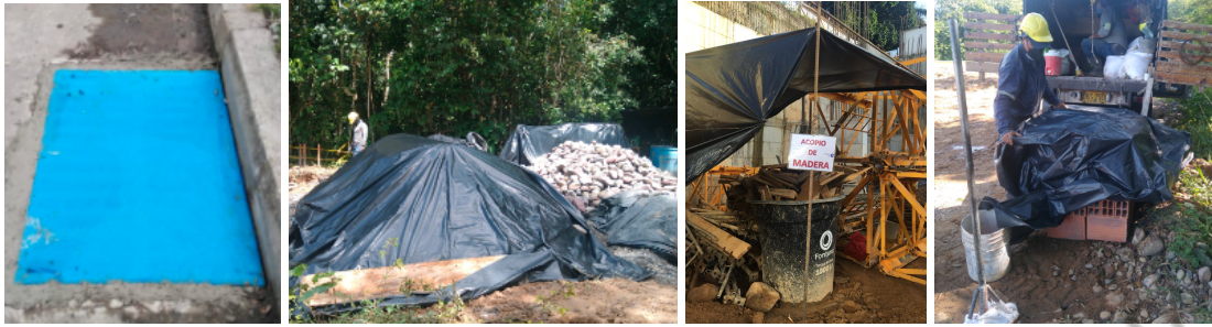
Imagen 11. Recomendaciones acopio de materiales en sitio
